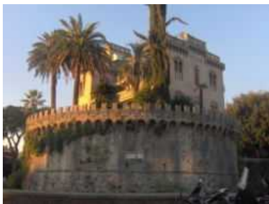
Villa Carpena sul Torrione Testaforte
